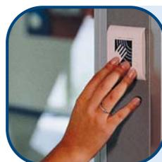
Бесконтактное устройство управления CAME - это пример дополнительного устройства, управляющего работой автоматических дверей, которое рассчитано на использование в местах с повышенными требованиями к санитарии, например, в больницах, госпиталях, поликлиниках и других учреждениях. (Бесконтактный датчик MS 9502)
